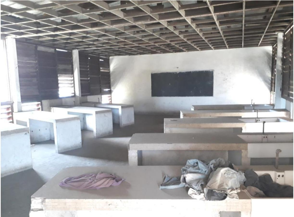
Dans la 2<sup>nd</sup>e grande salle, les anciennes paillasses en béton devront être préalablement enlevées pour permettre l'installation de rayonnages ; certaines paillasses pourraient être gardées pour servir utilement de tables de tri des archives.
