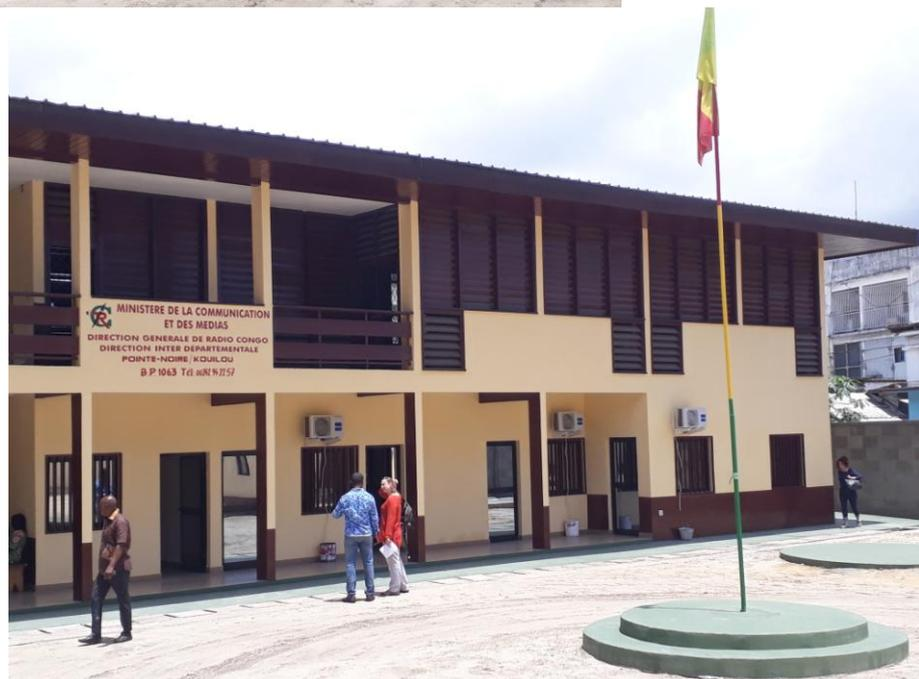
Le 1<sup>er</sup> étage est accessible par un escalier central, donnant sur un couloir desservant 3 salles. Cet étage nécessite quelques travaux de réhabilitation pour devenir un bâtiment d'archives, la priorité étant d'assurer le clos et le couvert (réfection de la toiture, changement de quelques lames de claustras, installation de portes à la place des grilles, etc.) Après visite et échanges, il a été proposé de retenir l'organisation suivante :
